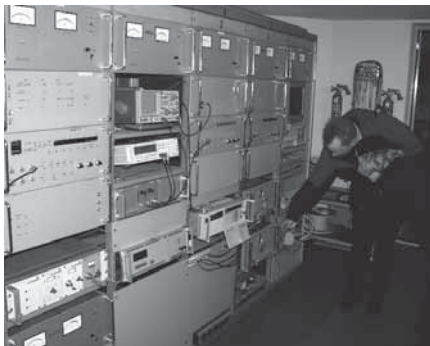
Obr. 4 - Pohľad do súčasného vybavenia vysielča, vpravo by mali byť dvojica céziových hodín a tretie záložné
