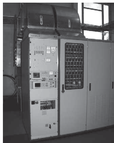
Obr. 2 - Vzduchom chladený 50 kW vysielač DCF77 - za sklom je 50 polovodičových modulov, každý z výkonom 1kW
