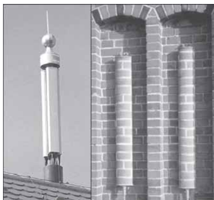
Obr. 4 – Kuriózní instalace anténních systémů
