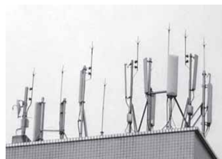
Obr. 5 – Instalace více různých antén na jedné střeše
