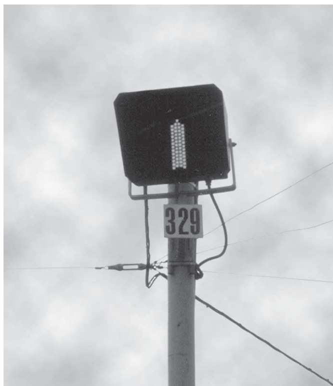
Obr. 3 - Světelná signalizace na tramvajové křižovatce
